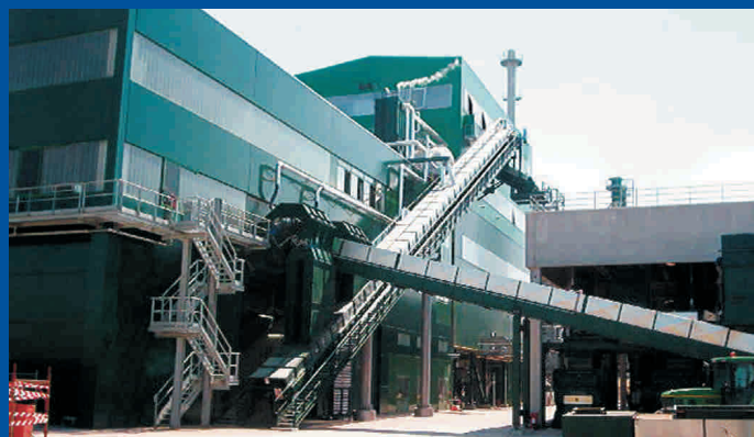
Linea di trasporto CDR Waste conveying plant
