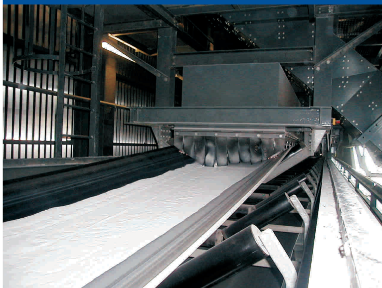
Stazione di carico Loading station
