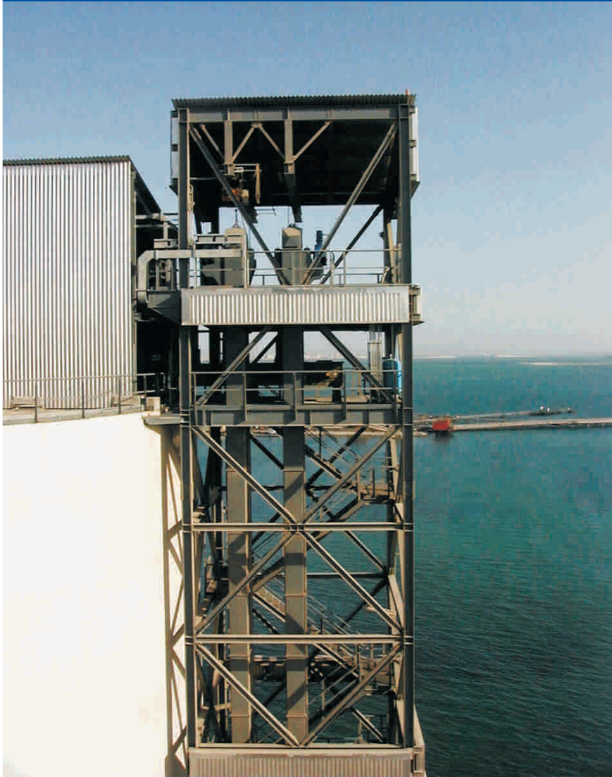
Bahrain - Impianto calcinazione coke di petrolio Bahrain - Coke calcining plant
