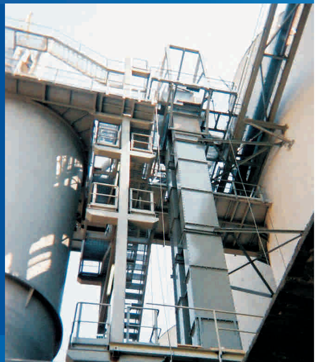
Italia - Impianto spedizione cemento sfuso Italy - Cement delivery plant
