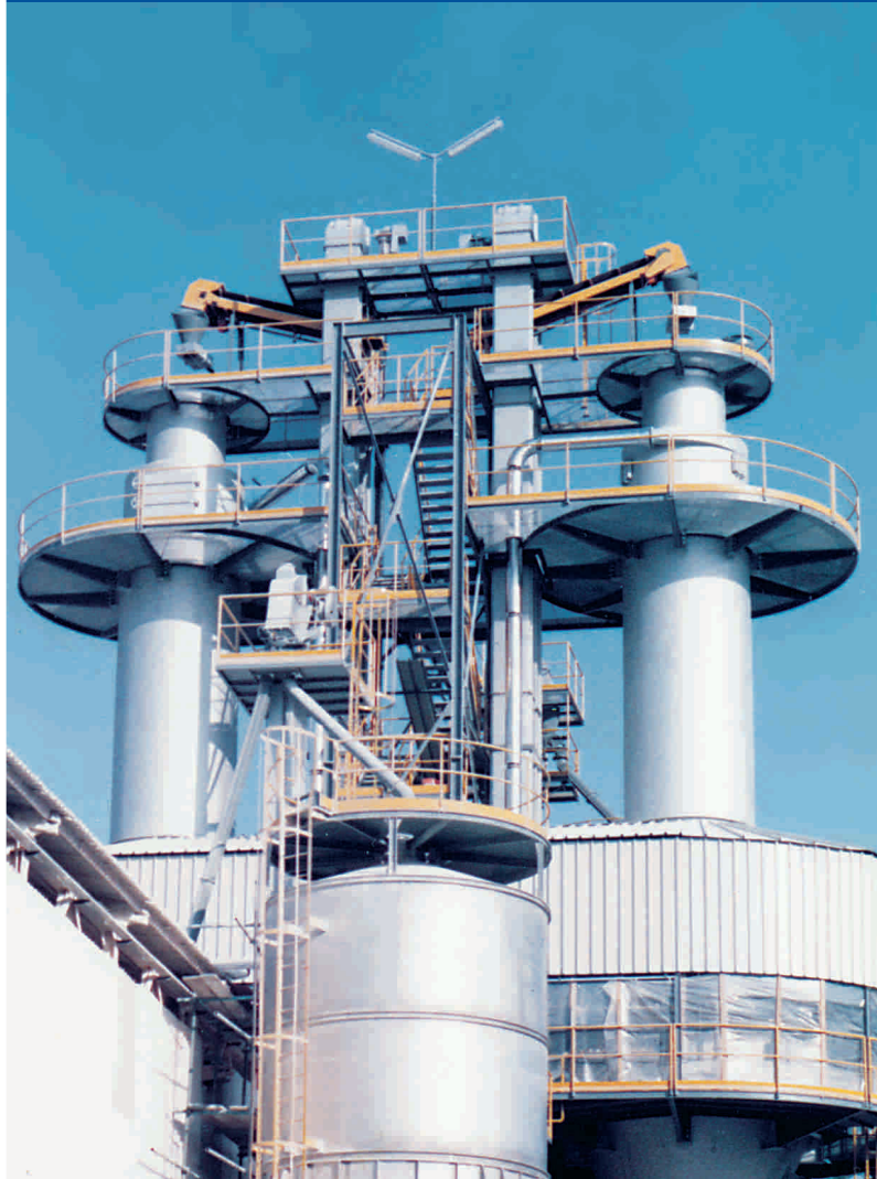
Italia - Impianto di calcinaazione Italy - Calcining plant
